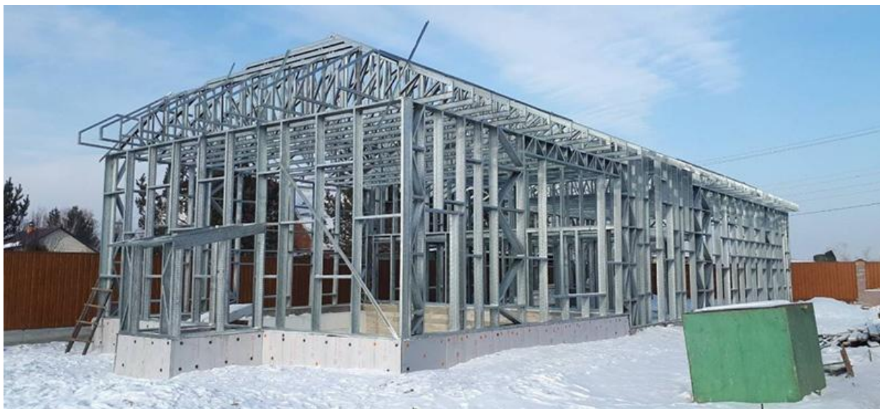
Рисунок 1 – Несущий каркас жилого здания из ЛСТК
