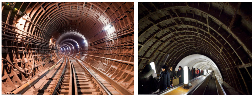
Рисунок 1. Выработки, закрепленные тюбингами
