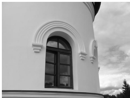
Рисунок 3 – Изготовленные арки на фасаде часовни в честь Тихвинской иконы Божией Матери
