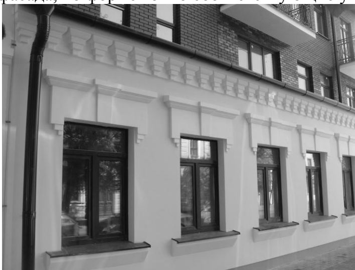
Рисунок 6 – Элементы декора на фасаде здания по ул. К. Маркса 56, г. Брест
