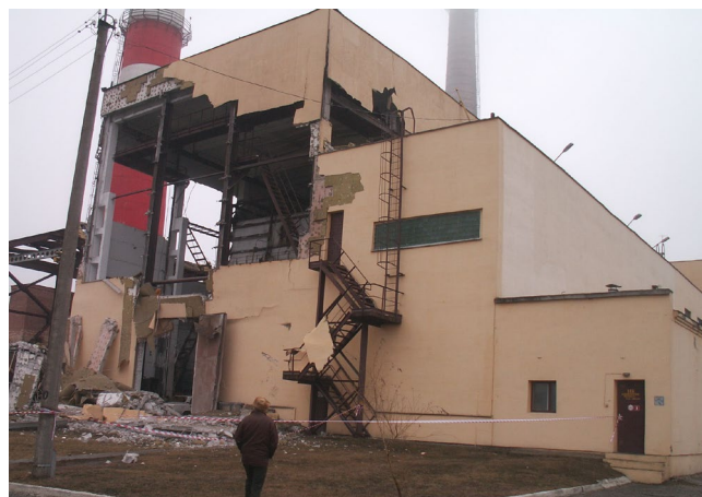
Рис. 1. Общий вид главного корпуса после взрыва
