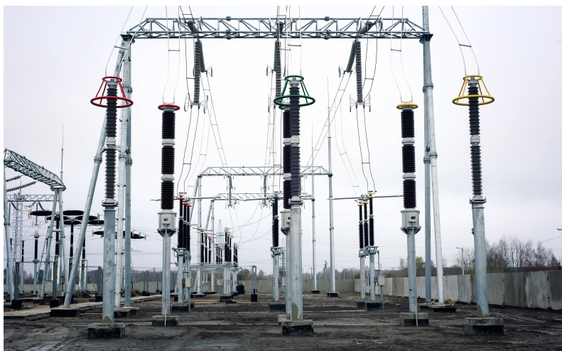
Рис. 2 – Ячейка ОРУ-330 кВ Березовской ГРЭС
