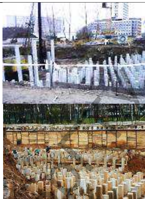
Рис. 3. Свайное поле после забивки (а) и подготовленное под устройство ростверков (б)
