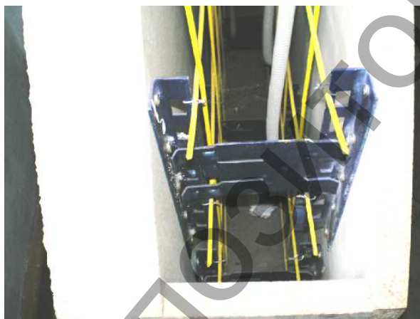
Рис. 1. Фрагмент элемента несъемной опалубки стены из ЦСП
