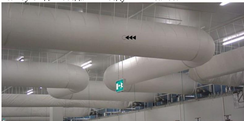
Рисунок 1. Воздухораспределительная сеть из текстильных воздуховодов.
