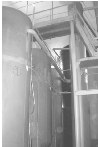
Рисунок 4 - Пенополистирольные фильтры с технологическими трубопроводами
