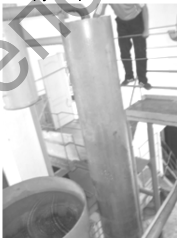
Рисунок 4 - Пенополистирольные фильтры с технологическими трубопроводами
