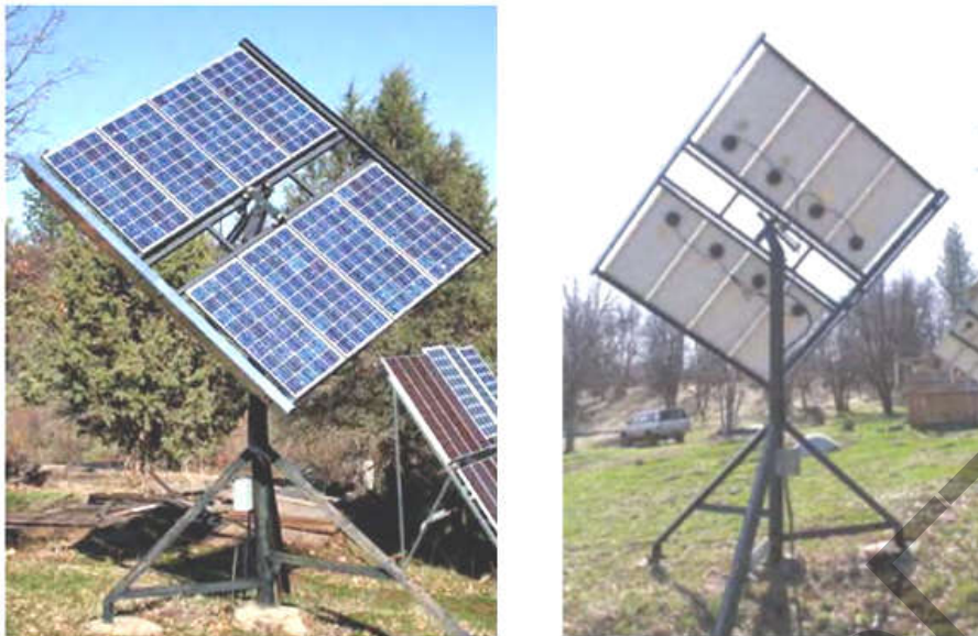
Рисунок 2 – Установка с пассивной системой слежения
