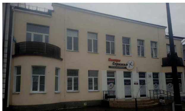
Рисунок 1 – Общий вид жилого дома по ул. Карбышева, 30 в г. Бресте
