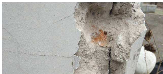
Рисунок 4 – Фрагмент отбора проб штукатурки
