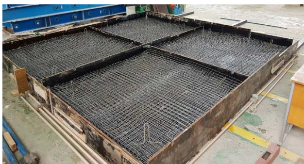
Рисунок 3 – Установка арматурных каркасов при изготовлении первой серии плит
