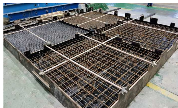
Рисунок 4 – Установка арматурных каркасов при изготовлении второй серии плит
