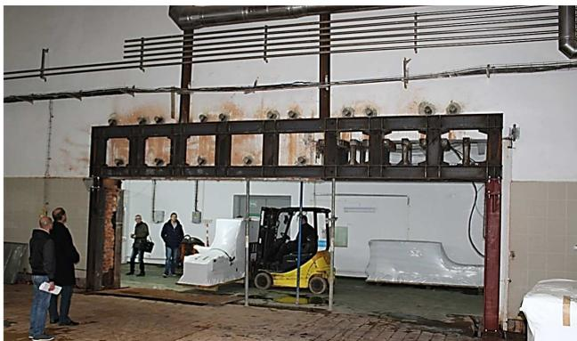
Рисунок 2 – Общий вид усиленного проёма со стороны производственных помещений (сырцеха)
