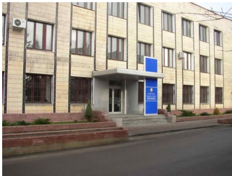
Административное здание Брестэнерго
