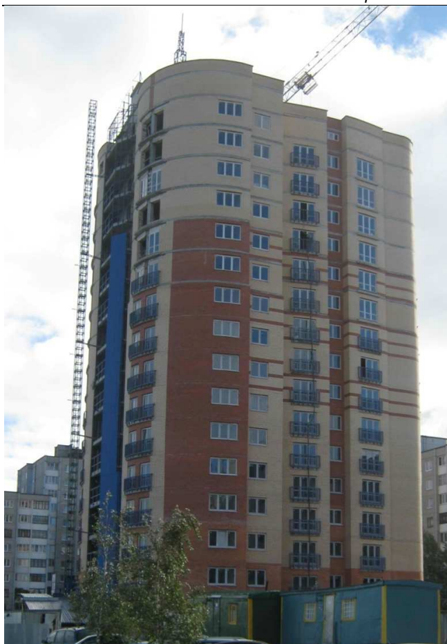
Рис. 1. Общий вид здания
