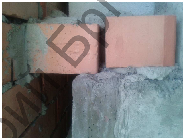
Рис. 3. Опирание тычкового ряда на перекрытие в местах наибольших отклонений
