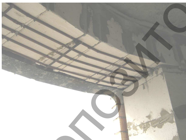
Рис. 2. Перемычки над криволинейным проемом
