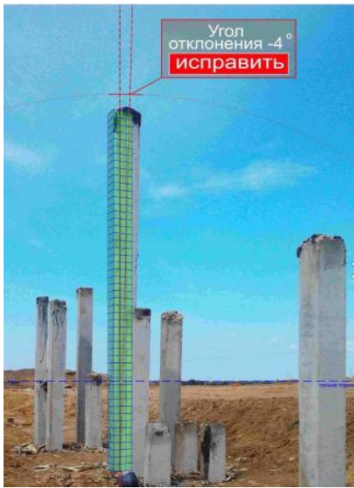
Рисунок 1 – Исполнительная съемка свайного поля
