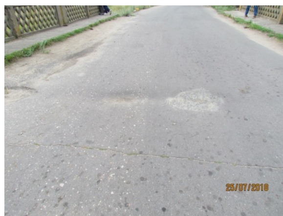
Рисунок 2 – Отсутствие дорожного ограждения на мосту, перелом профиля на сопряжении
