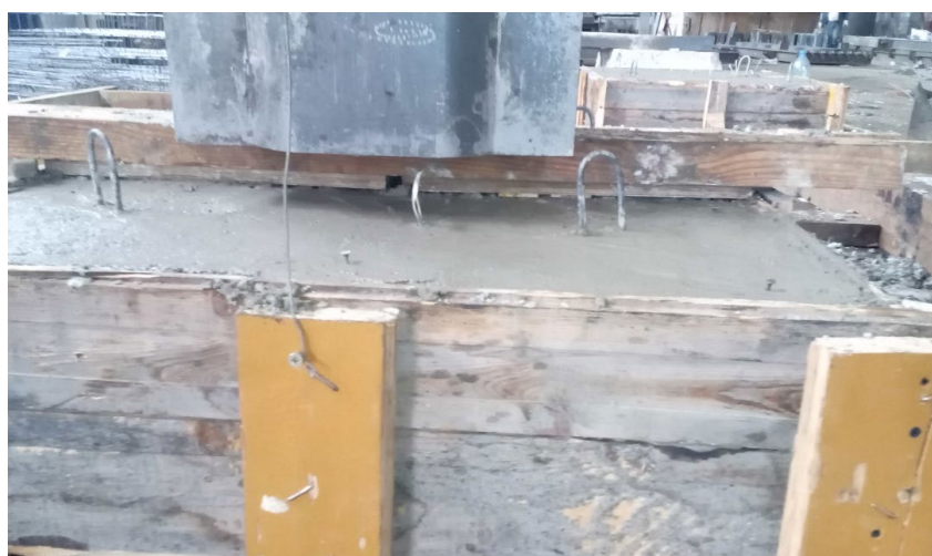
Рисунок 3 – Устройство пригруза
