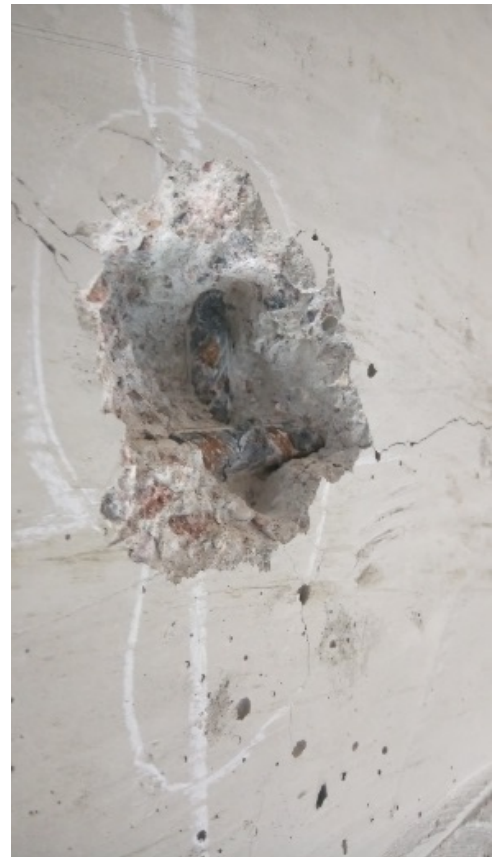
Рисунок 2 – Общий вид характерных трещин
