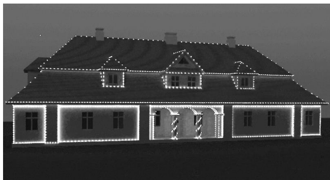
Рис. 2. Пример “рождественского” освещения здания в исторической застройке по ул. Леваневского
