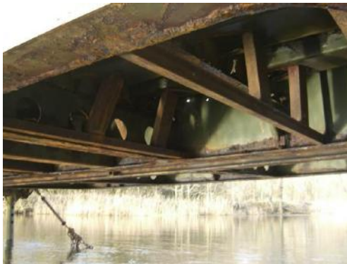
Рис. 5. Усиление стального настила и поперечных и продольных балок «хозспособом»
