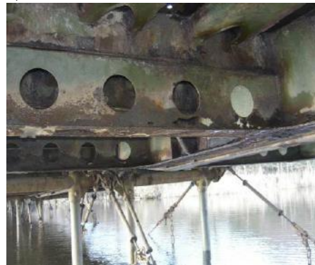
Рис. 6. Коррозия элементов моста
