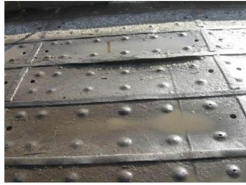
Рис. 4. Дефекты и усиление стального настила
