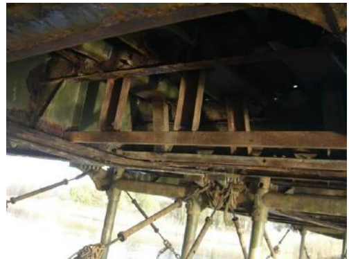
Рис. 5. Усиление стального настила и поперечных и продольных балок «хозспособом»
