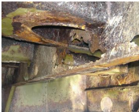
Рис. 6. Коррозия элементов моста
