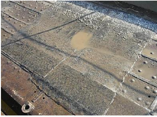
Рис. 4. Дефекты и усиление стального настила
