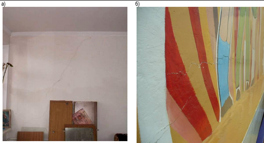
Рис. 2. Характер трещинообразования в сплошных перегородках а) при 1,2 \leq L/H \leq 2 ; б) при L/H > 2
