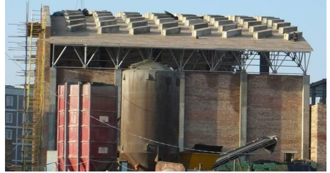
Рис. 4. Общий вид покрытия, нагруженного испытательной нагрузкой
