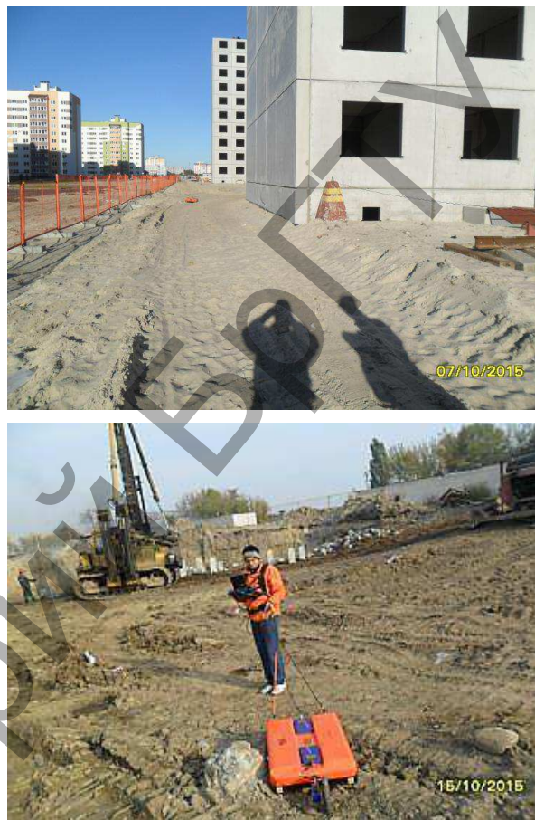
Рис. 2. Общий вид стройплощадок и рабочий момент георадиолокационного обследования
