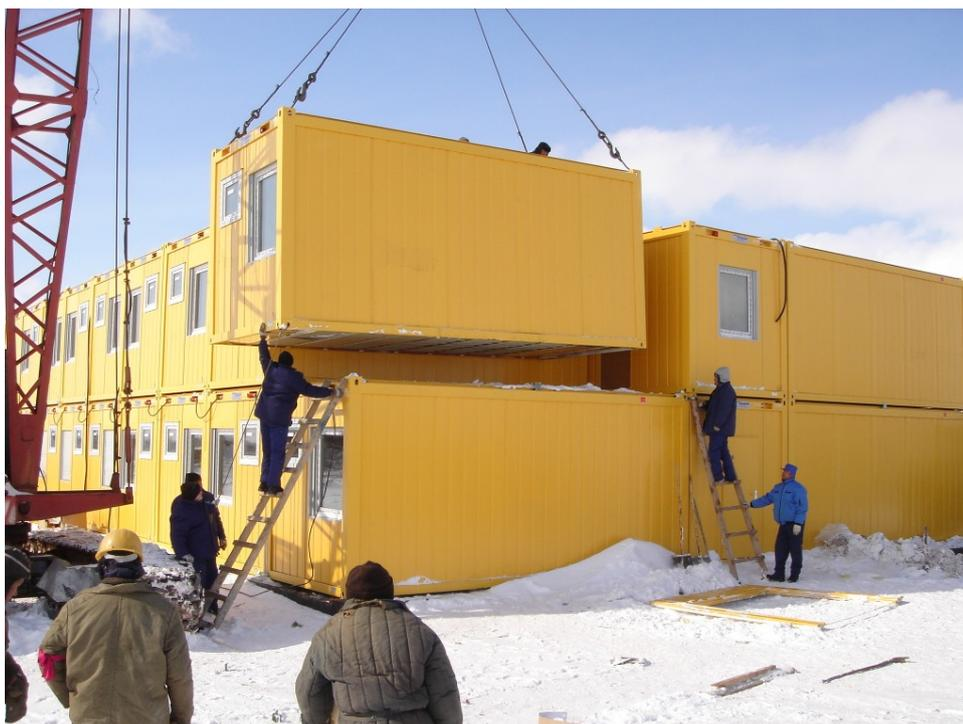
*Рисунок 2 Пример эргономически верного размещения бытовок на строительной площадке*
