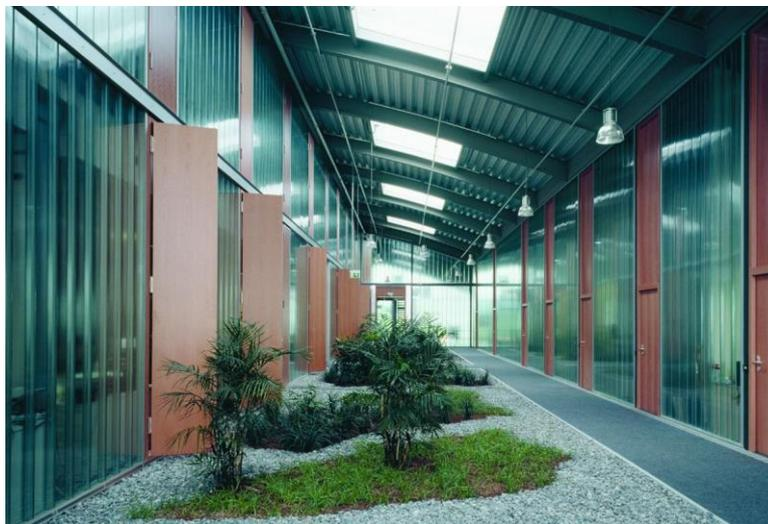
**Рисунок 10.5 – Перегородки из стеклопрофилита**
