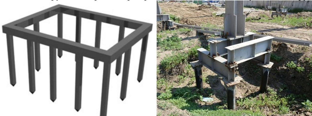
Рисунок 4.18 – Ростверки свайных фундаментов
