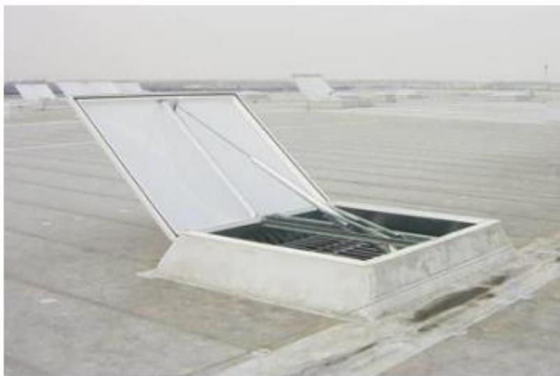
Рисунок 17.5 – Фонарь дымоудаляющий с функцией дополнительного освещения
