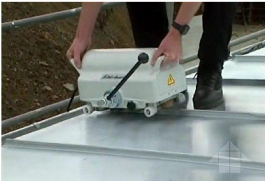
Рисунок 9.9 – Устройство фальцевой кровли
