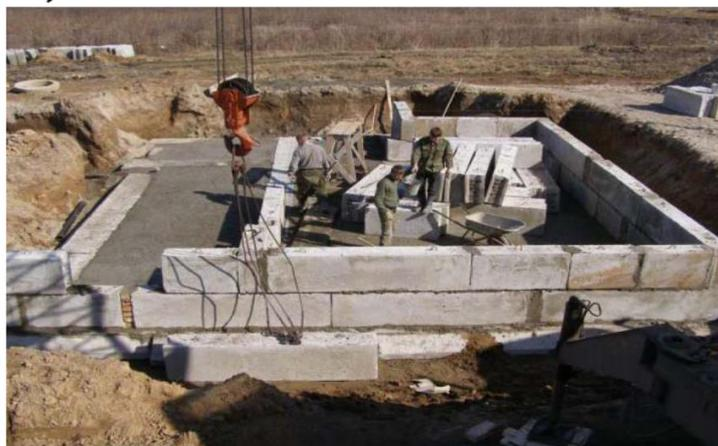
**Рисунок 3.3.4 – Сборные железобетонные ленточные фундаменты**
