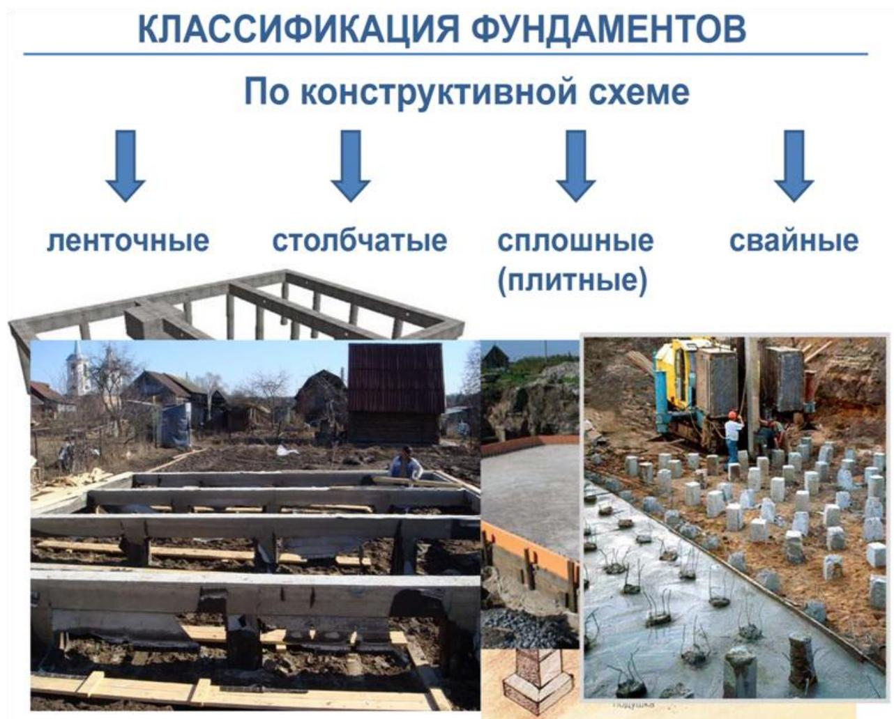
*Рисунок 3.1.1 – Классификация фундаментов по конструктивной схеме*
