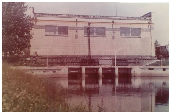
Рисунок 4.13 – Мелиоративная насосная станция
