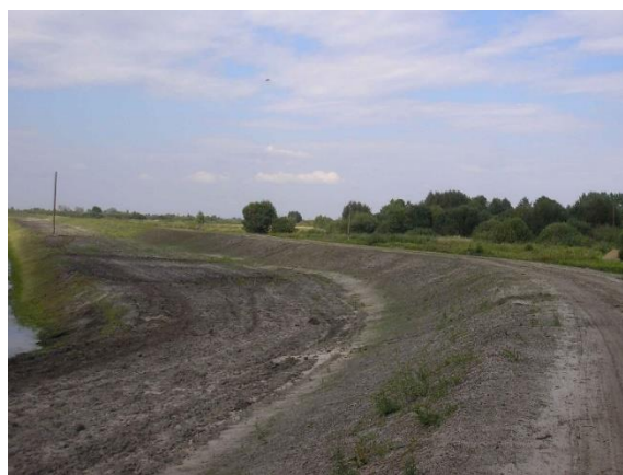
Рисунок 4.18 – Обвалование пойменных земель
