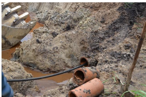
Рисунок 4.22 – Ремонт и восстановление мелиоративной сети
