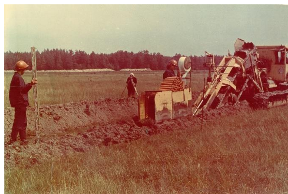
Рисунок 4.11 – Строительство закрытого материального дренажа
