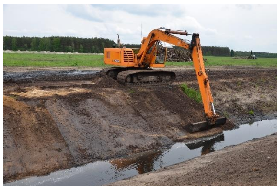
Рисунок 4.22 – Ремонт и восстановление мелиоративной сети
