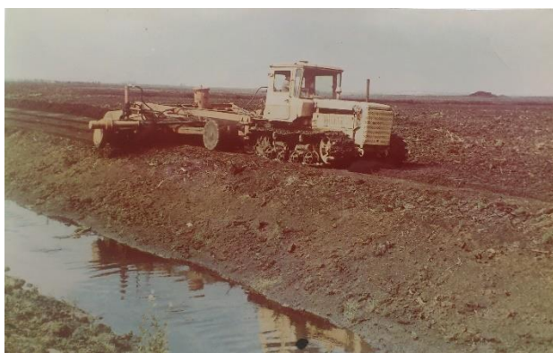
Рисунок 4.10 – Строительство осушительного канала
