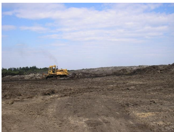
Рисунок 4.18 – Обвалование пойменных земель
