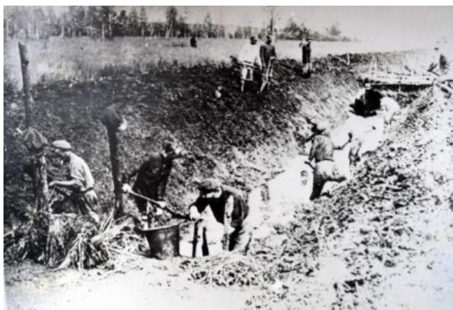
Рисунок 4.8 – Работы по устройству канала
