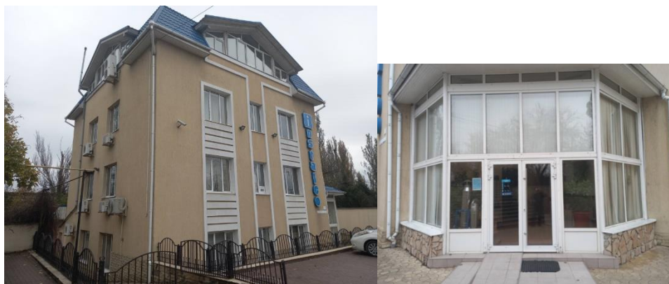
Рисунок 1 – Коммерческий центр INSTALCO
