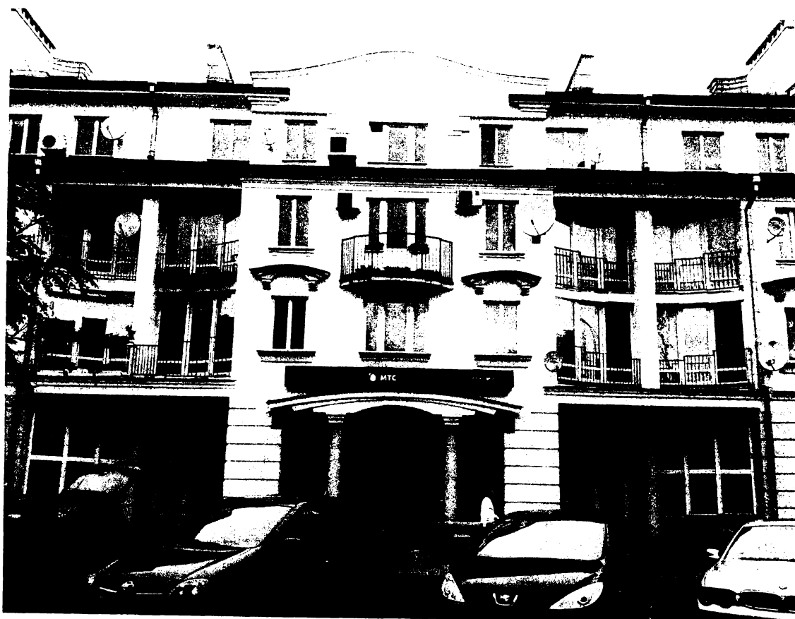
Рисунок 6 – Реконструкция жилого здания по пр-ту Машерова, г. Брест
