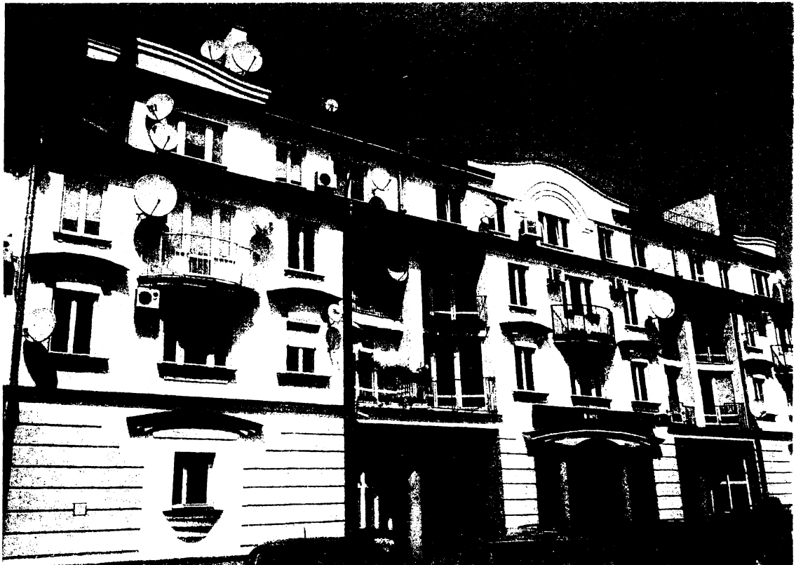
Рисунок 7 – Реконструкция жилого здания по пр-ту Машерова, г. Брест
