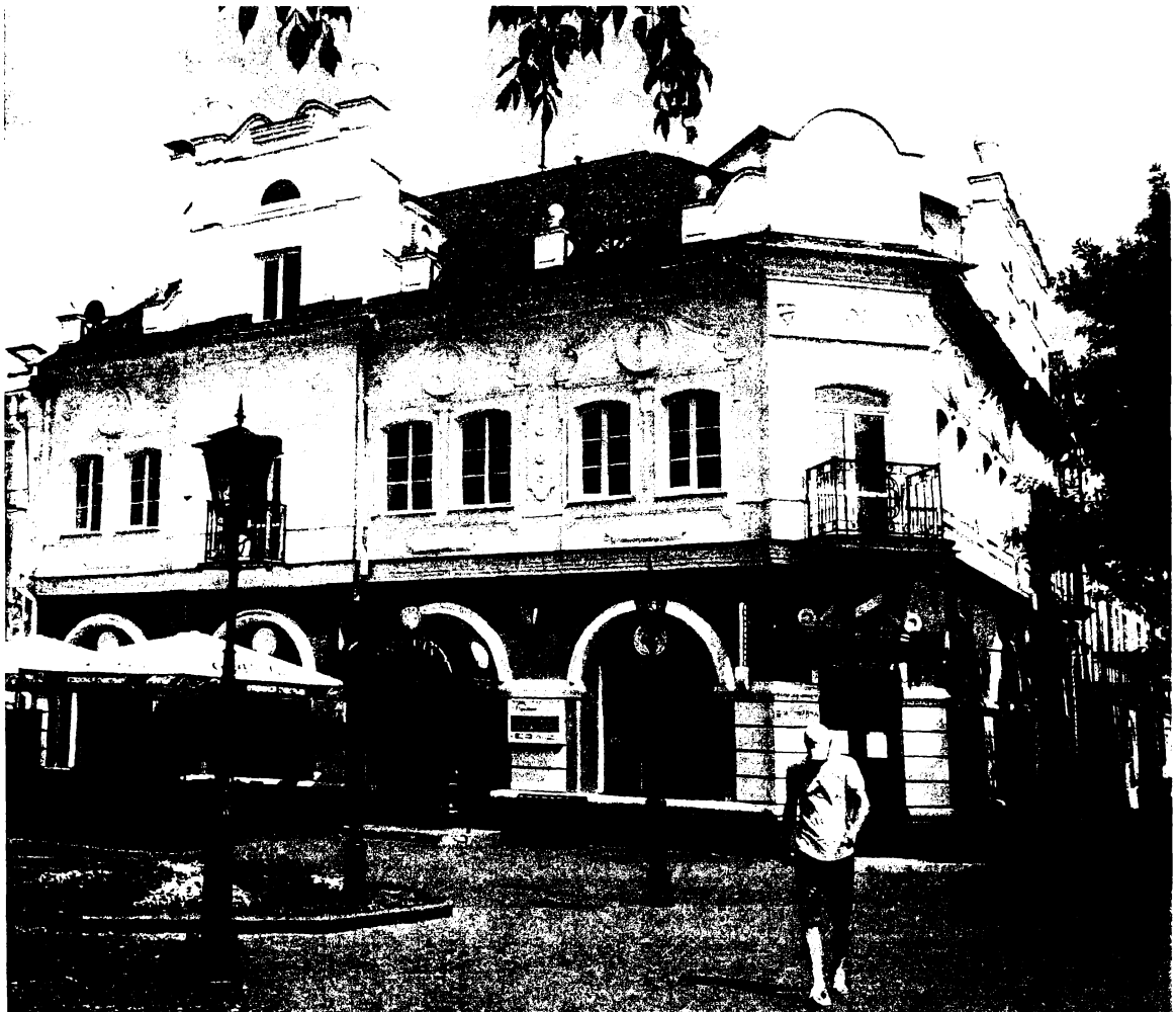
Рисунок 8 – Реконструкция жилого здания по ул. Советская, г. Брест
