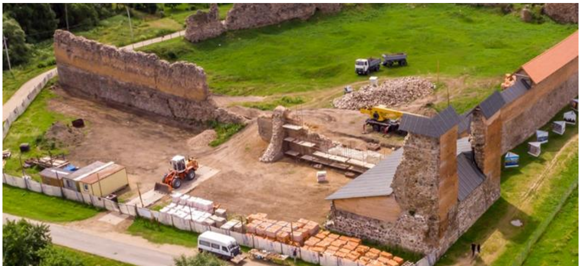
Рисунок 4 – Реставрационные работы замка
