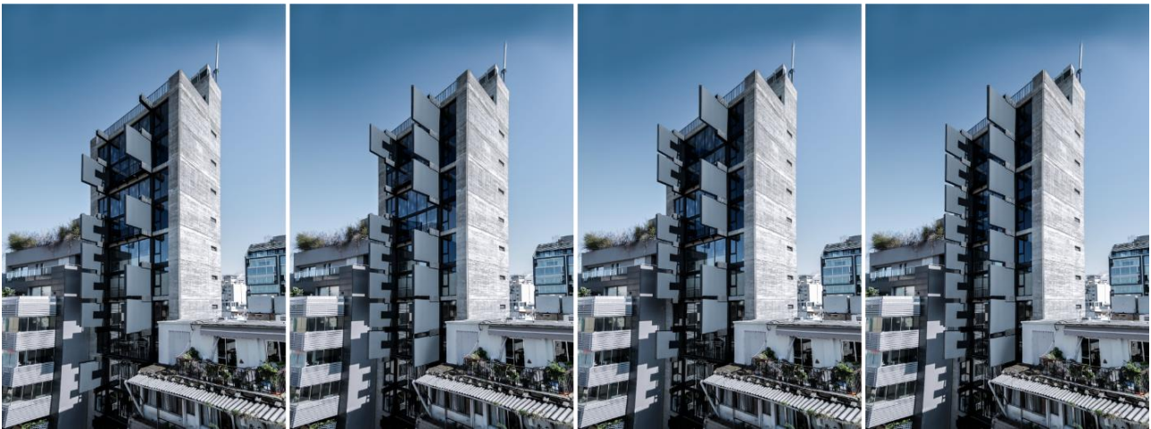
Рисунок 2 – Здание с выдвижными стенами
