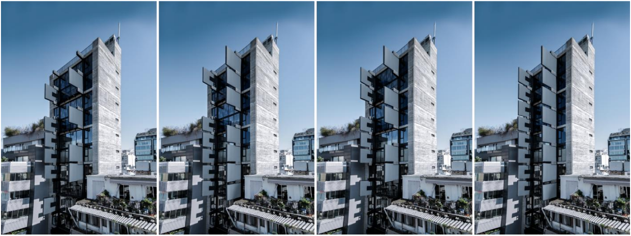
Рисунок 2 – Здание с выдвижными стенами
