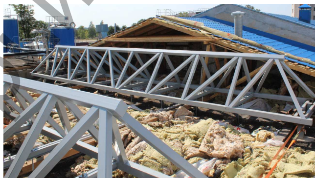
Рисунок 3 – Общий вид трёхгранных ферм из гнутосварных профилей
