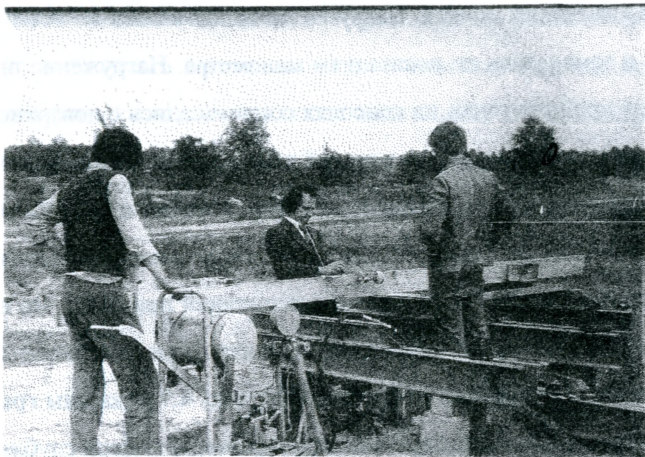
Рис. 4.5. Подготовка к испытаниям фундаментной ленты из плит ФЛпб на глубине 0,2 м
