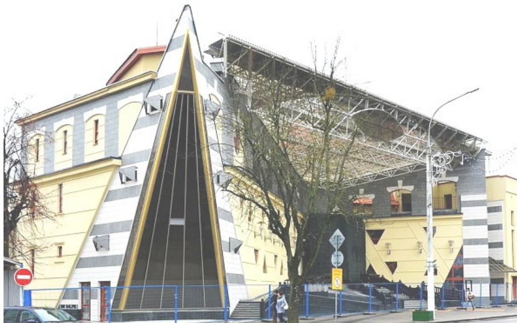
Рисунок 1 – Общий вид здания театра кукол в г. Бресте
