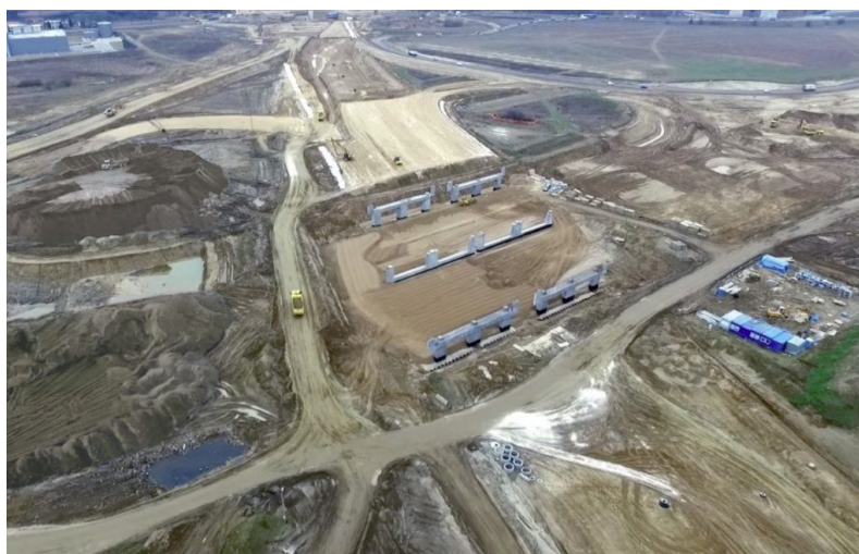
Fot.12 – Monitorowanie budowy obwodnicy miasta Ostrydy – droga krajowa 16 i S7 (Generalny wykonawca firma Budimex) – Autor: SkySnap ( urydio: drony w budownictwie.pl ).
