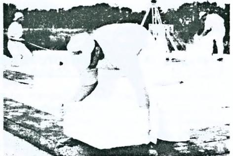
Устройство гидроизоляции и укладка углового блока первого ряда
