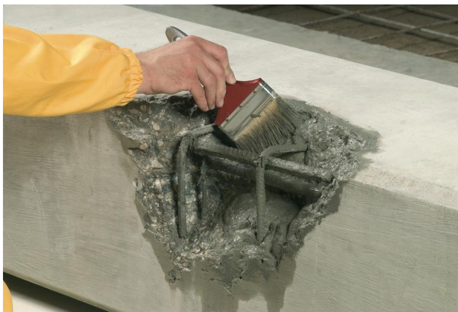
Рисунок 5 – Комплексная защита бетона от коррозии
