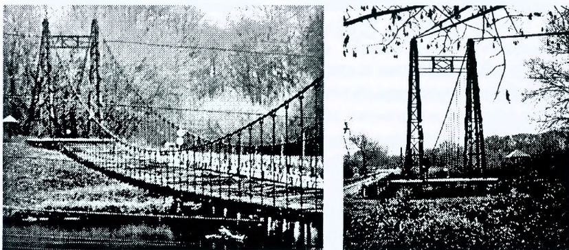
Рис. 2. Общий вид моста до реконструкции
