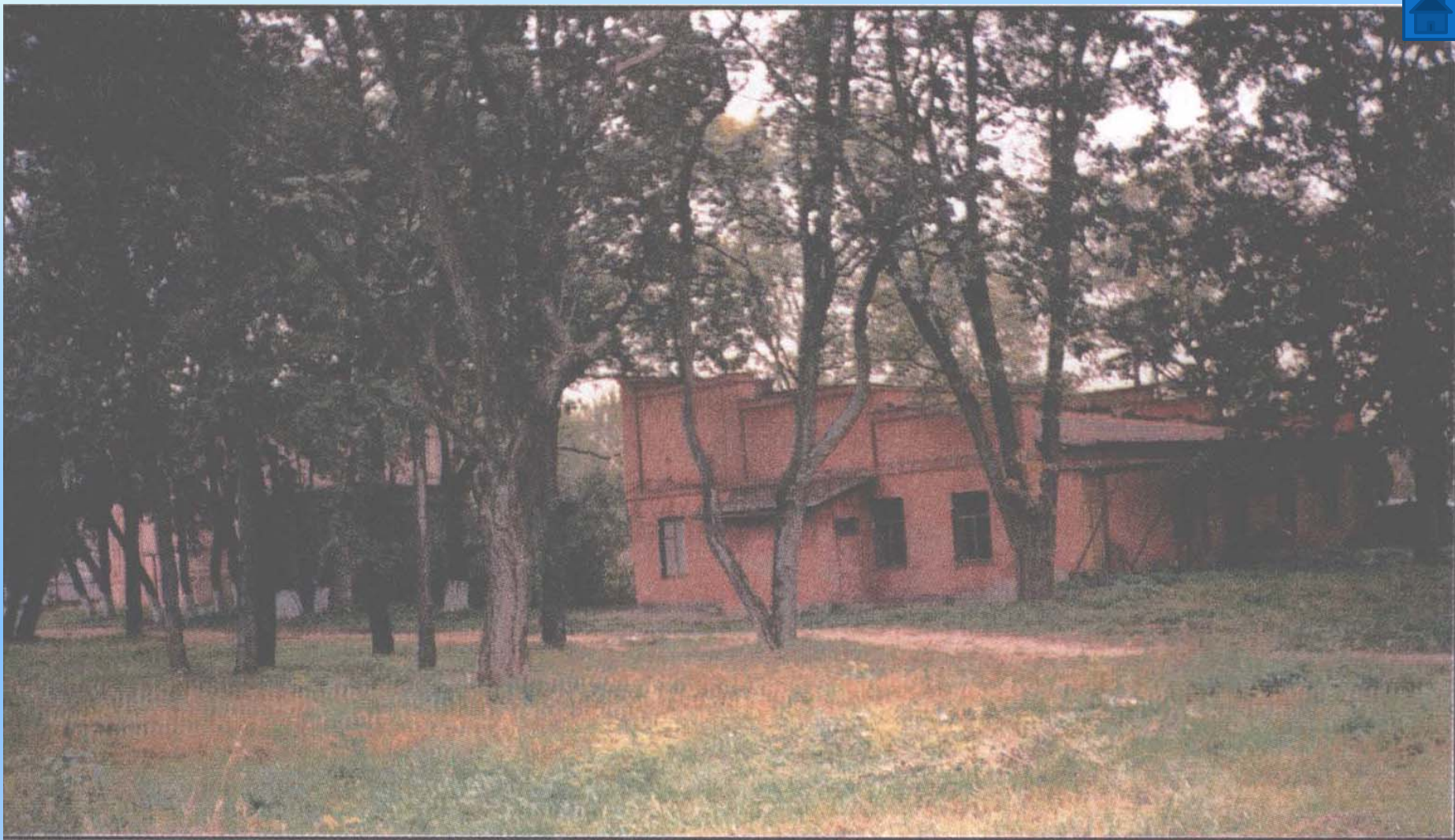
Рисунок 3 - Первая насосная станция городского водопровода
