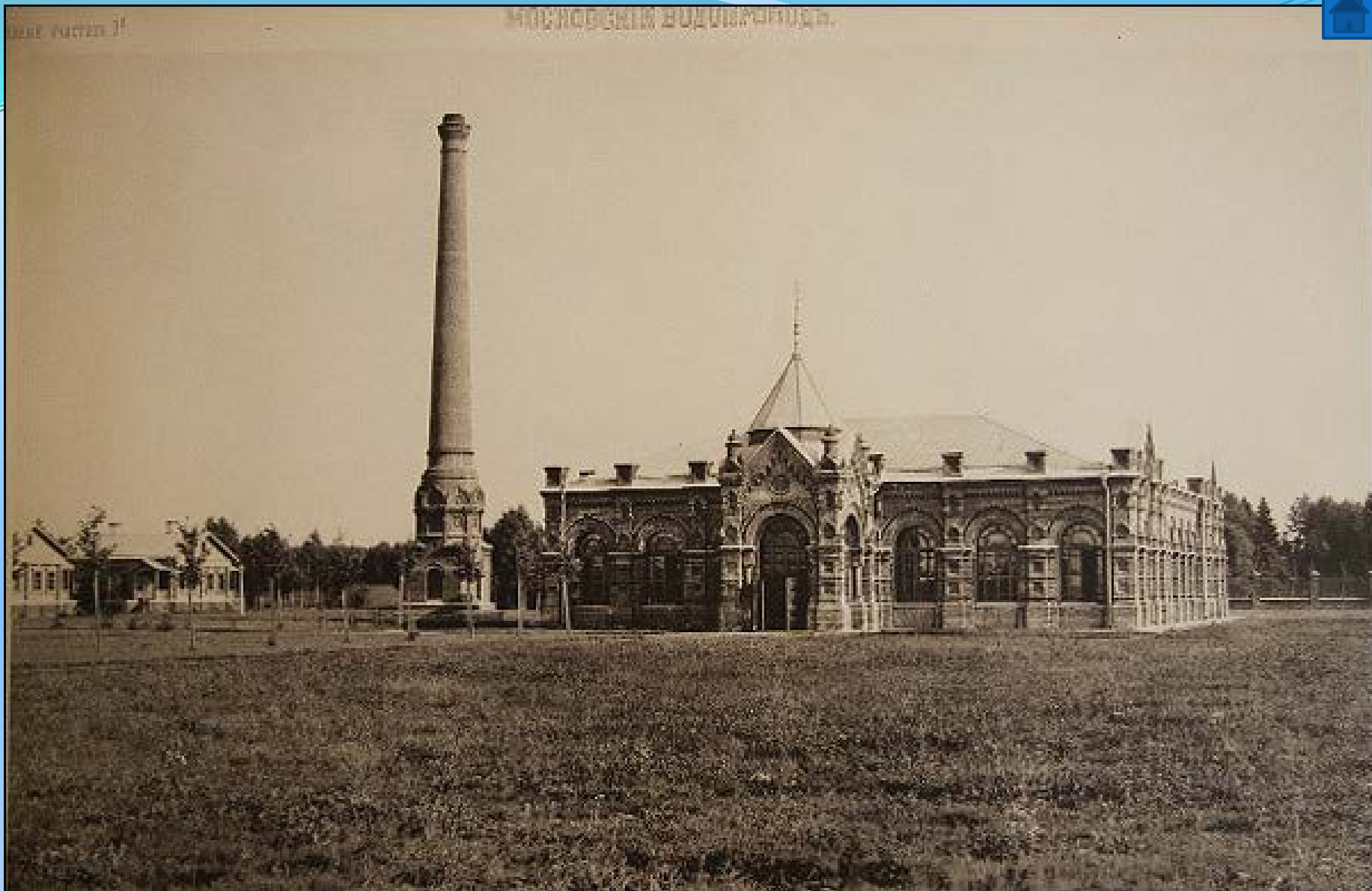
Рисунок 14 - Мытищинское водоподъемное здание
