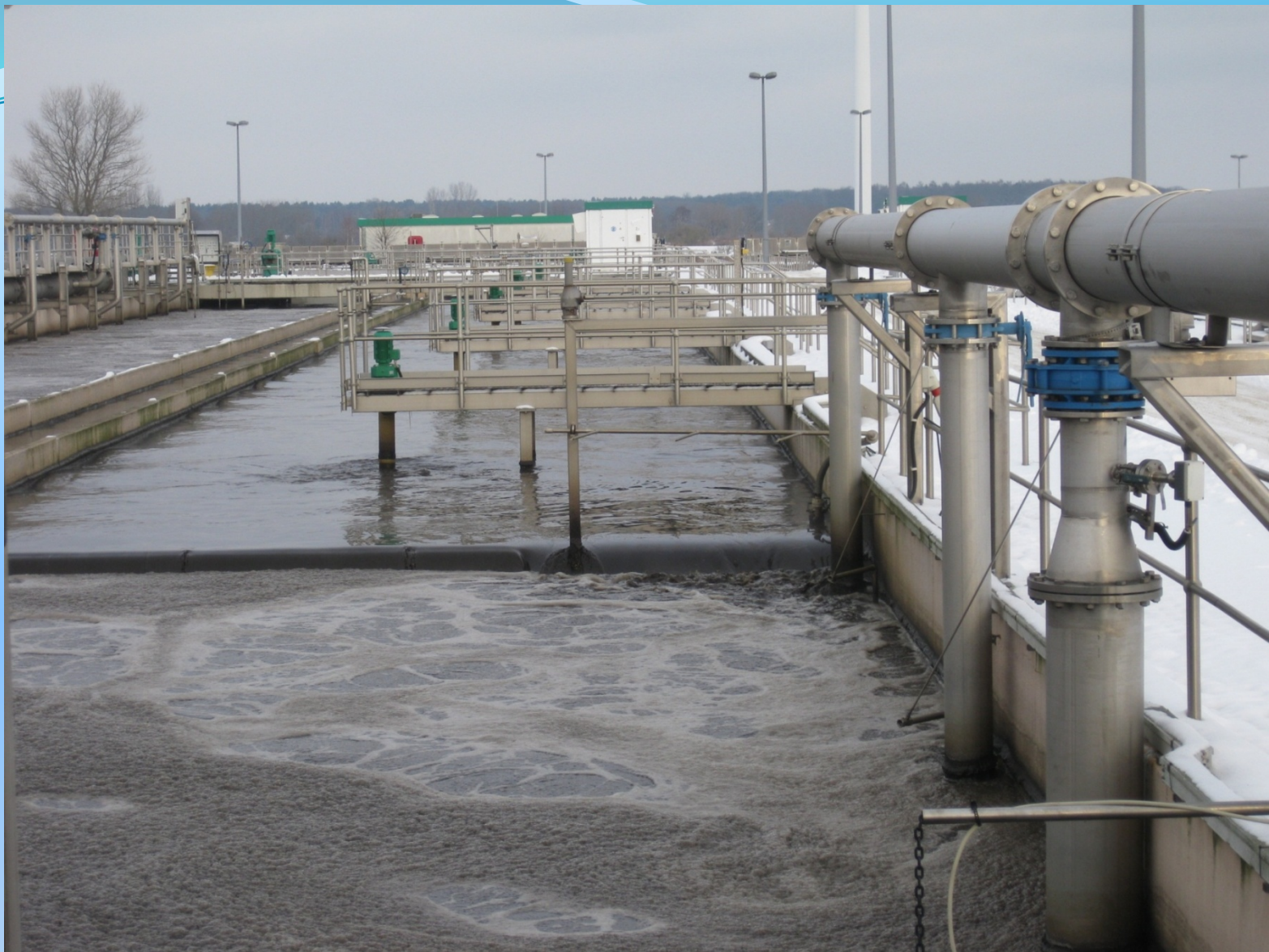
Рисунок 9 – Аэротенк станция «Шёнерлинде» г. Берлина
