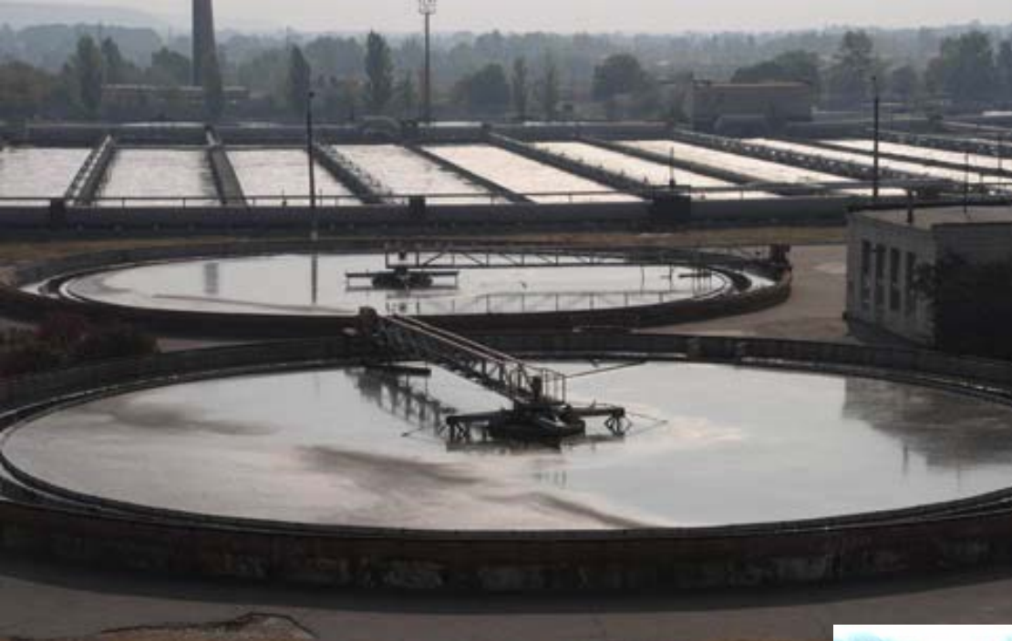
Рисунок 5 - Первичные радиальные отстойники. Общий вид двух отстойников
