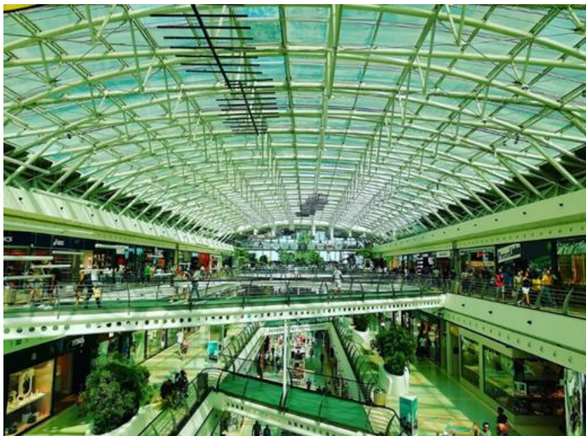
Фото 9 – Торговый центр Vasco da Gama, Лиссабон, Португалия. Дизайн атриума данного ТЦ решен стеклянным прозрачным куполом на крыше, заливающим естественным светом все этажи торгового центра. В атриуме расположены эскалаторы, лифты, мостики и пр.
