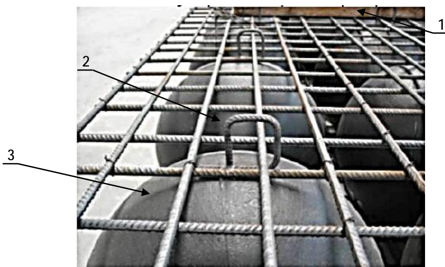
1 – временная нагрузка; 2 – металлические петли; 3 – пустотообразователи модульные Sobiax «Eco-Line»
