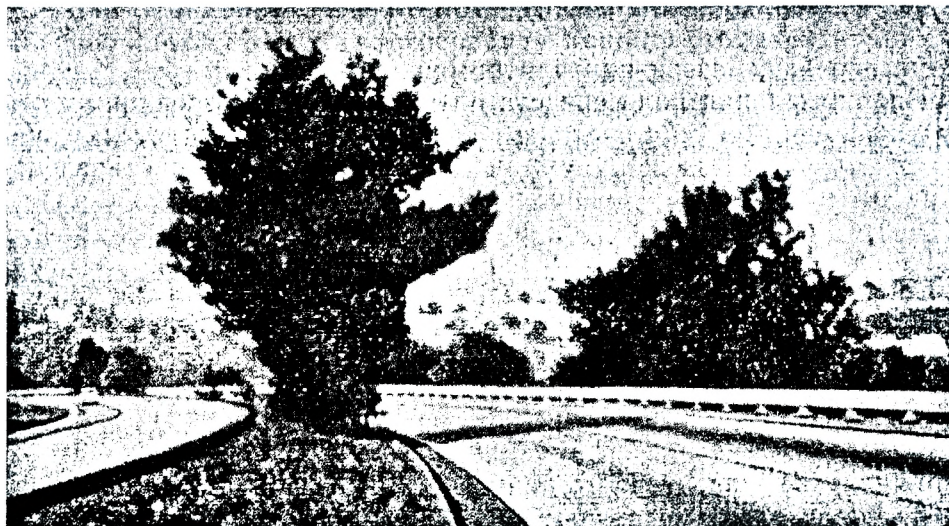
Рис. 17.7. Направляющее действие ограждений барьерного типа
