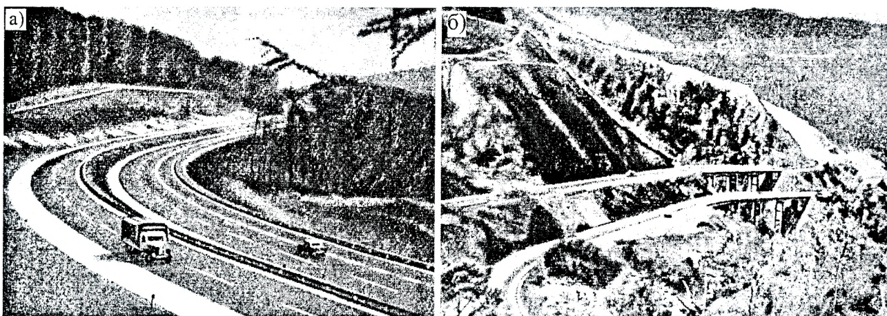
Рис. 17.37. Ступенчатое расположение проезжих частей на косогоре: а – при малой разнице высот; б – при большой разнице высот
