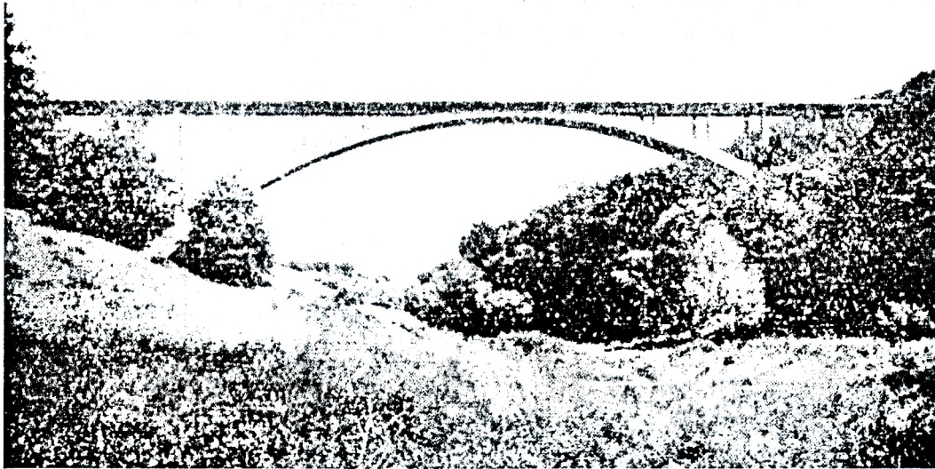
Рис. 17.80. Виадук на автомагистрали, перекрывающий долину с пологими склонами
