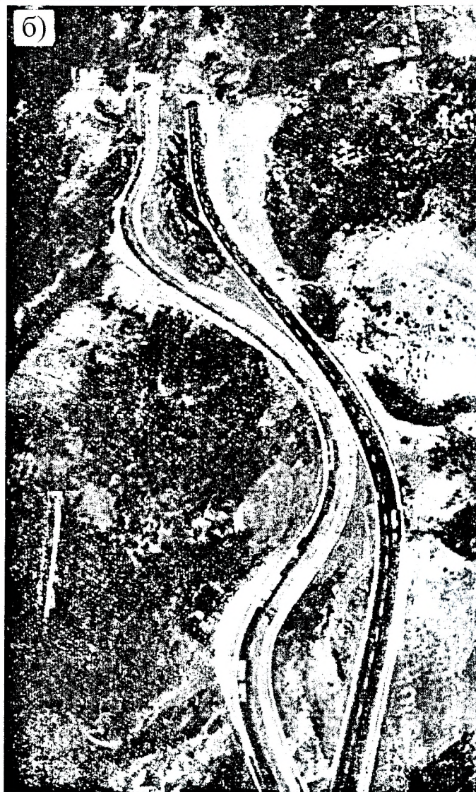
Рис. 17.39. Раздельное трассирование проезжих частей на косогоре
