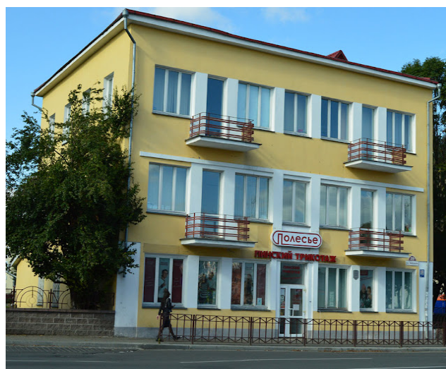
Рисунок 1 – Здание бывшего радиоузла по ул. Завальной
