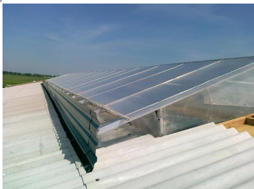
Рисунок 1 – Светоаэрационный конек
