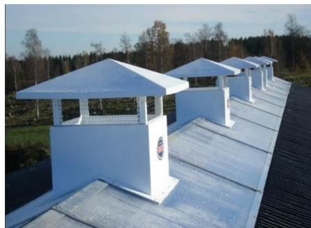
Рисунок 2 – Активные вытяжные крышные шахты
