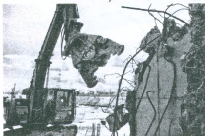
Рисунок 16.14 – Обрушение конструкций
