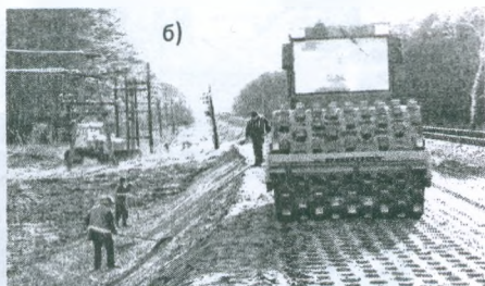
Рисунок 26.4 – Самоходный – а и прицепной – б кулачковые катки
