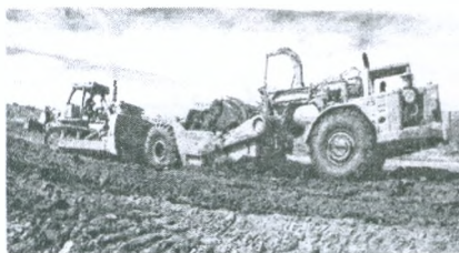
Рисунок 21.15 – Работа бульдозера-толкача
