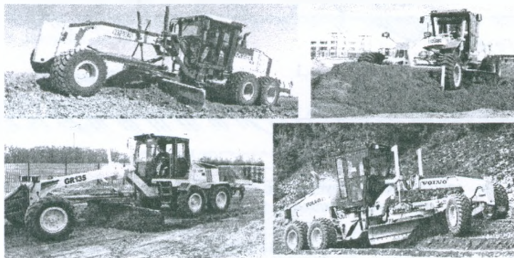
Рисунок 23.4 – Разработка и перемещение грунта грейдерами
