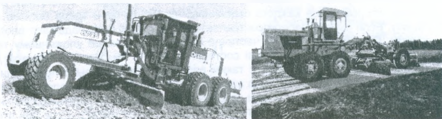
Рисунок 23.7 – Разравнивание грунта грейдером
