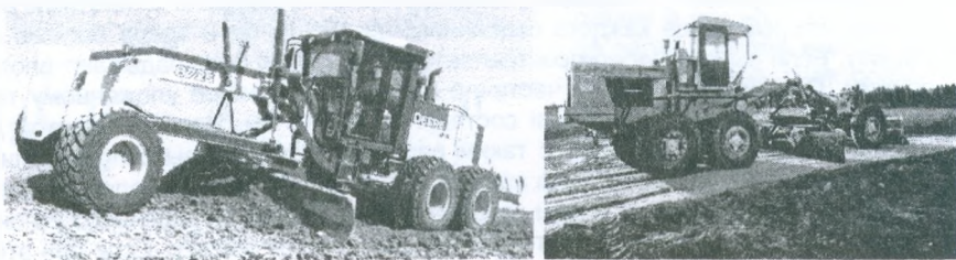
Рисунок 23.7 – Разравнивание грунта грейдером
