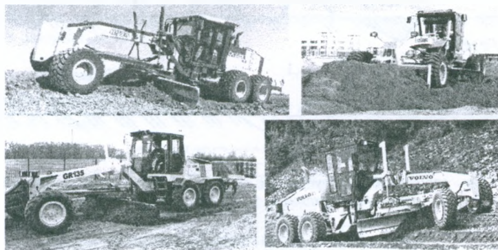
Рисунок 23.4 – Разработка и перемещение грунта грейдерами
