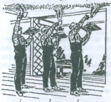
Рис. 45. Нанесение раствора на потолок
