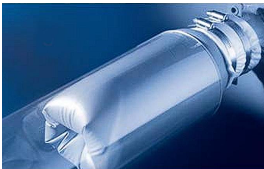
Рисунок 2 – Релайнинг методом «чужка»
