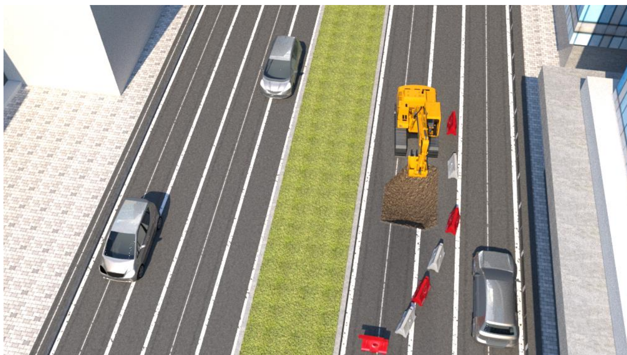
Рисунок 7.1 – Изготовление траншеи метро
