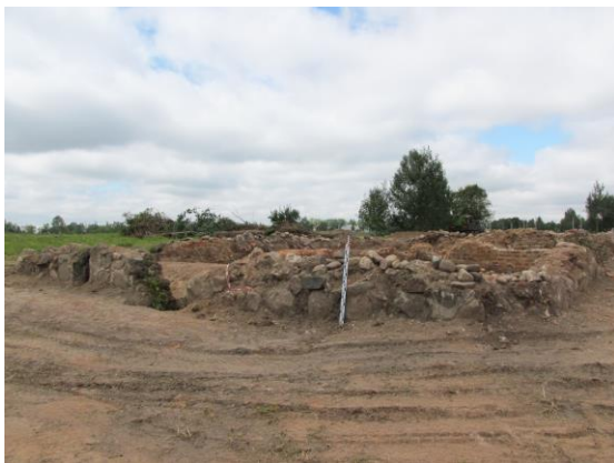
Фото 1 – Общий вид с востока на фундаменты усадебного дома на территории бывшего лагеря Малый Тростенец
