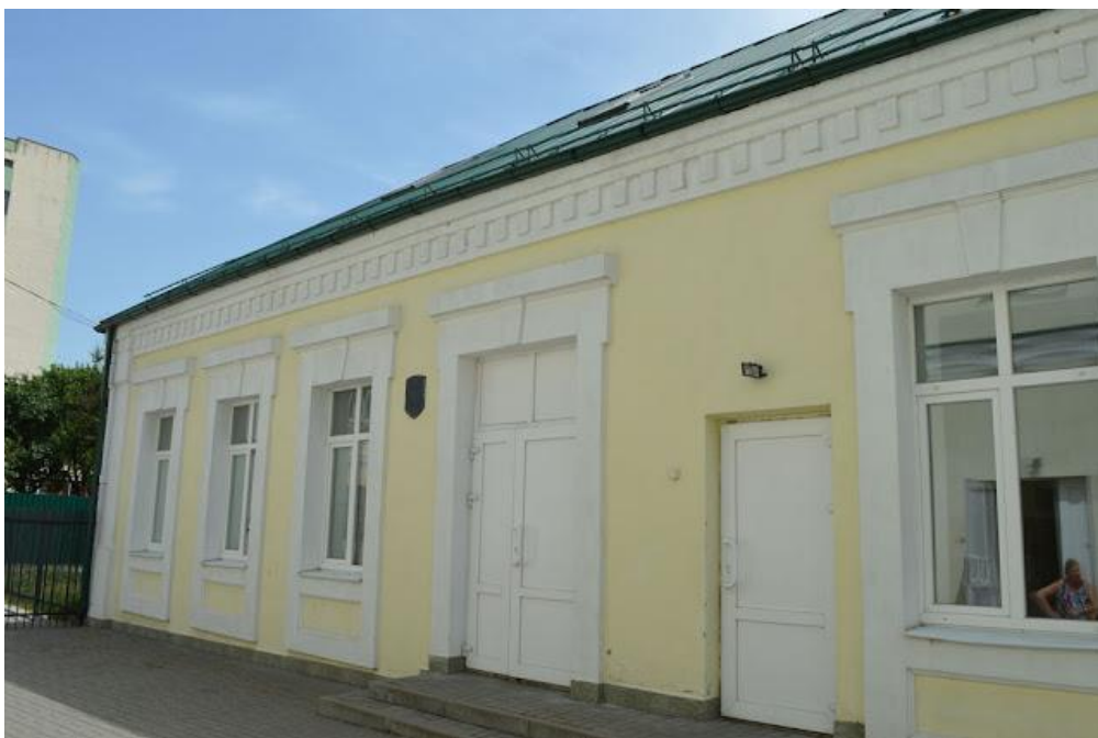
Рисунок 2 – Здание синагоги после реставрации (фасад)
