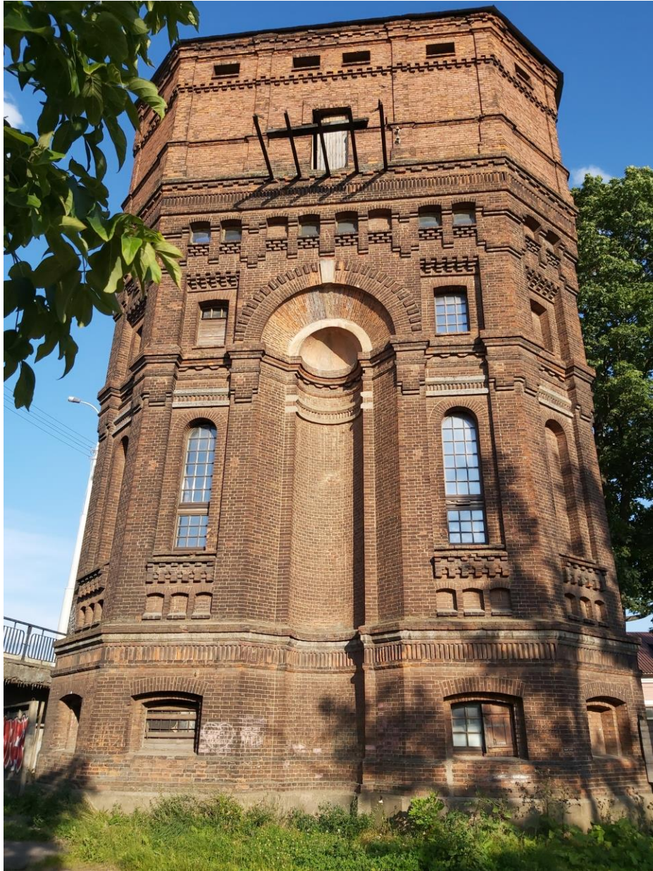
Рисунок 3 – Водонапорная башня начала XX века (Минск, Беларусь)
