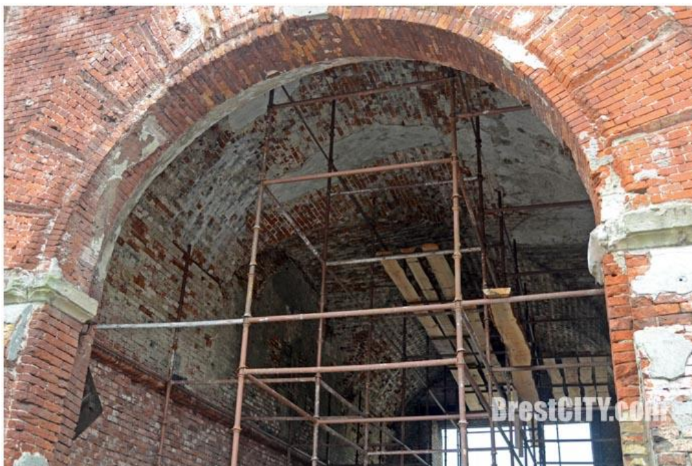
Рисунок 3 – Цилиндрический кирпичный свод над Тереспольскими воротами (Брестская крепость)
