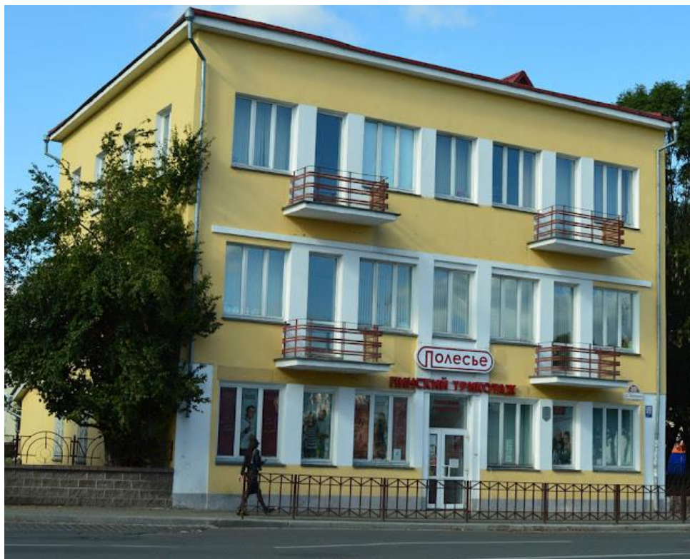
Рисунок 1 – Здание бывшего радиоузла по ул. Завальная
