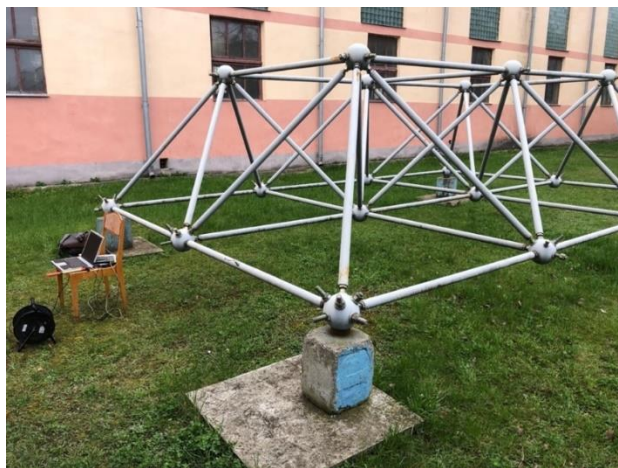
Рисунок 1 – Фрагмент структурной конструкции системы «БрГТУ»
